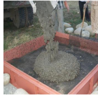
Fig 4(a). Concrete mix
